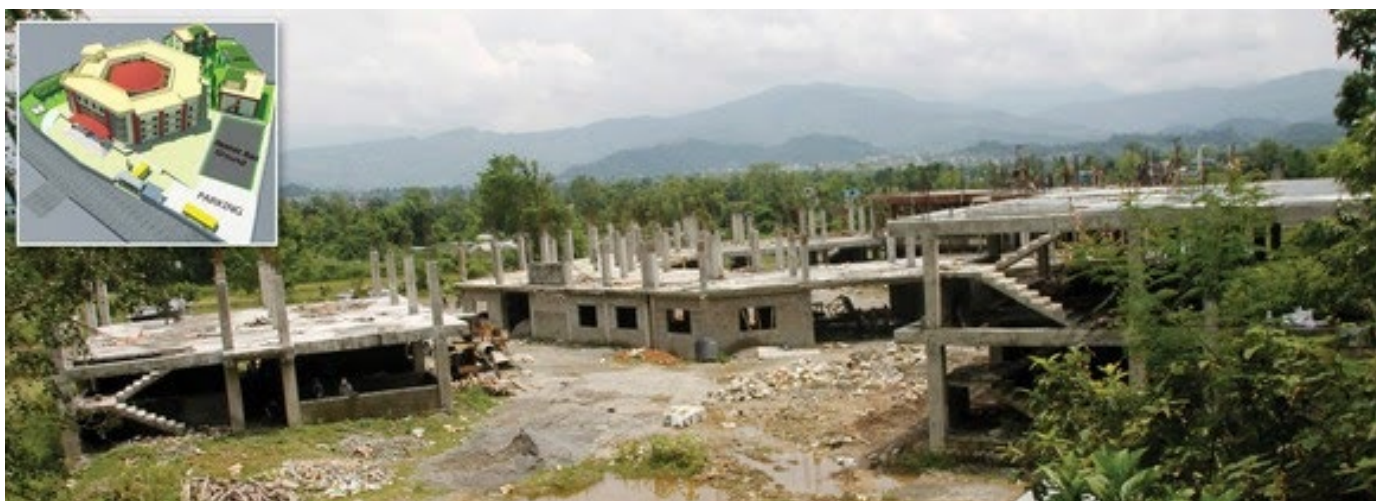
建設中の新校舎と完成予定図
